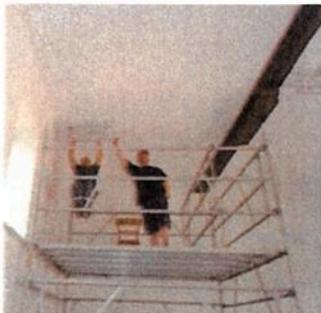
haben die Flure und Treppen abgeklebt, die Rigipsplatten von den Wänden entfernt und die Bretterwand für den Schallschutz ausgebaut. Sie verlegten Kabel für Licht und Akustik und brachten die Traverse an, die zur Befestigung von Scheinwerfern und Lautsprecher dienen. Ebenso installierten sie die notwendigen Vorrichtungen für Küche, Toilette und Behinderten WC. Die Holzhalle im Anschluss an das Pfarrheim wurde eingelegt, um die Außenisolierung beginnen zu können.
